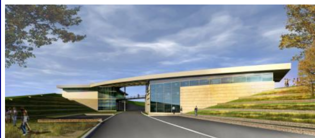
Entrée du site de Mainvilliers
